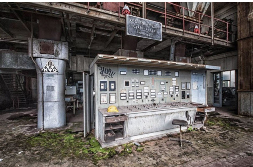
Chiếc mũ bảo hộ lao động vẫn còn nằm nguyên trên bàn điều khiển trong một nhà máy điện bỏ hoang ở Đức.
